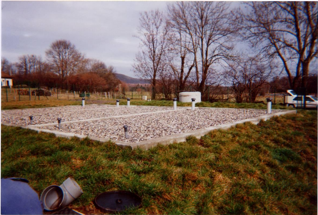
3 filtres à sable
