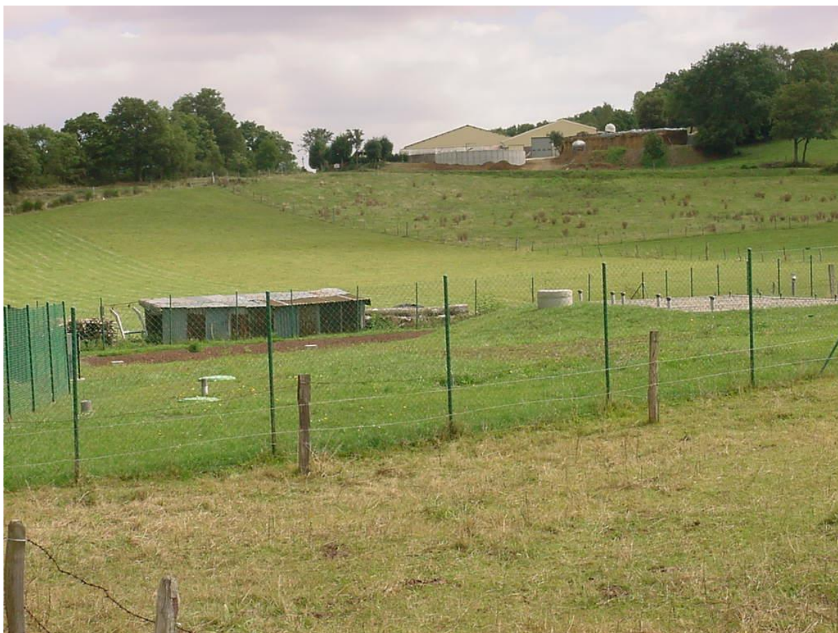
(Station de traitement d'Egales)
