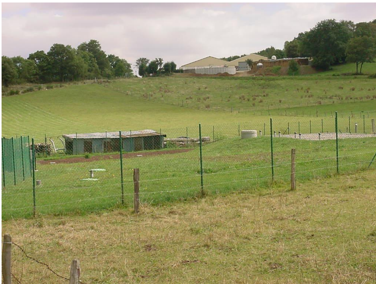
(Station de traitement d'Egales)
